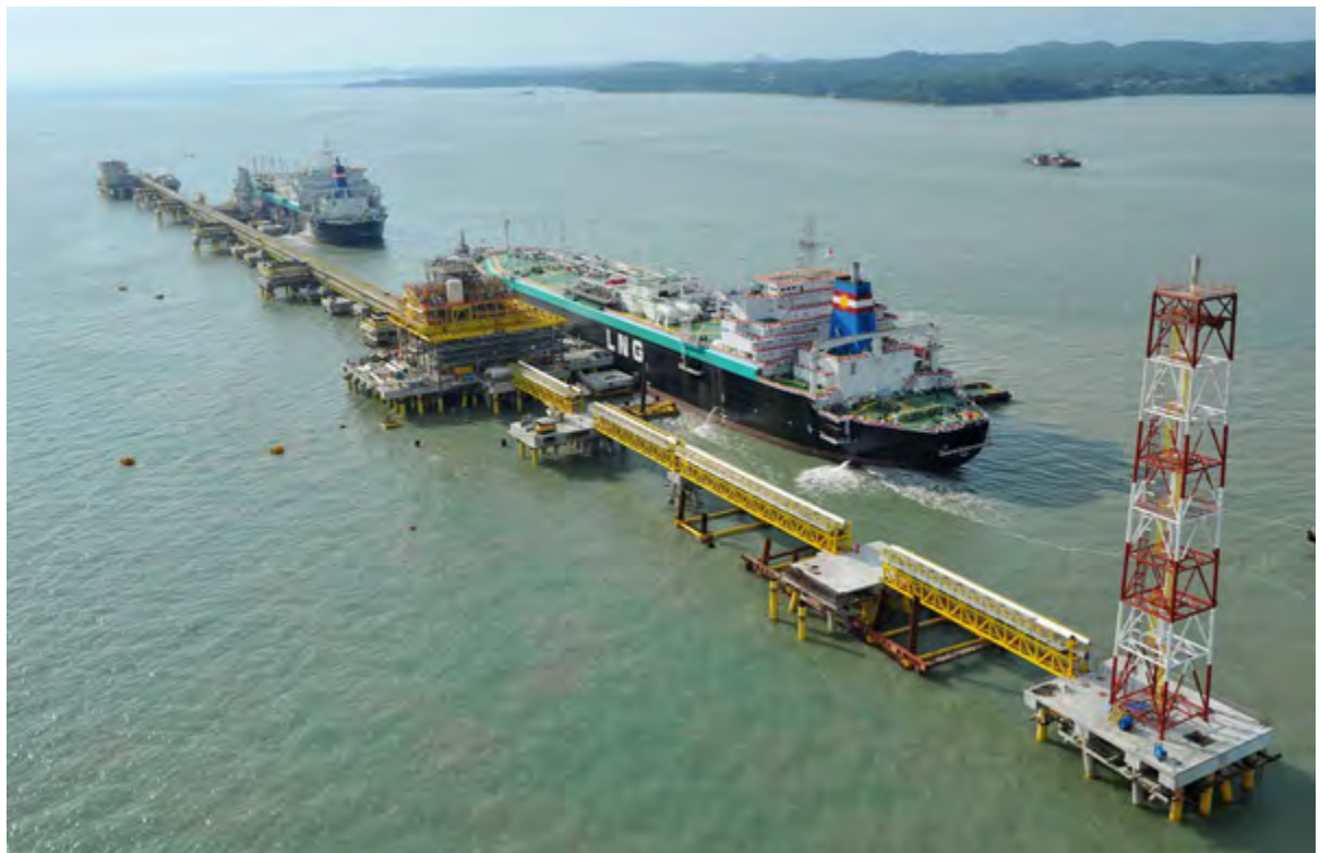
Exhibit 3-34: Melaka LNG Terminal
